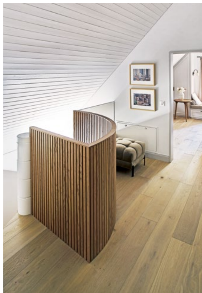
Die Brüstung der Wendeltreppe ließ Vanessa Cerasoli mit feinen Holzprofilen verkleiden. Wie in der Eingangsetage wurden auch im Dachgeschoss bis auf das Bad überall massive Eichendielen verlegt.
